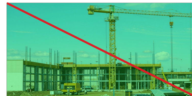
Использование некорректного фильтра
